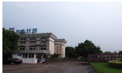
校外实训基地—污水处理厂
